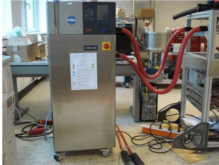
Chiller, Kältegerät Firma Huber
